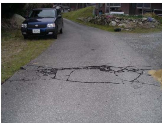
道路に亀裂が確認されるが、当初は段差が出来ていたものを補修したとのこと。南西側からの撮影で、南西側（写真の手前側）が低下している。
