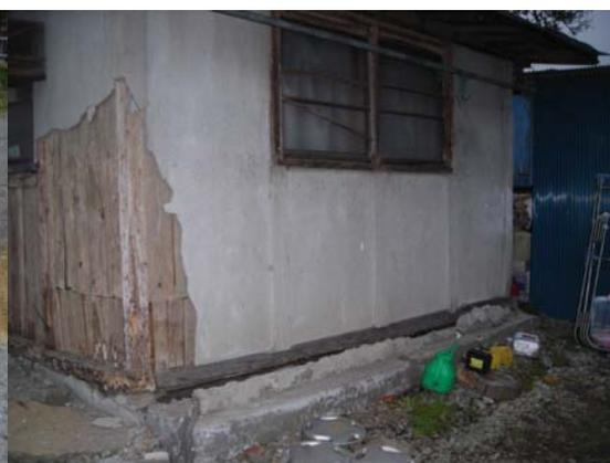
亀裂の南東延長上の家屋では土台に段差が確認される。建物と土台とが分離している。東側から撮影。4月11日の地震により変形したとのこと。
