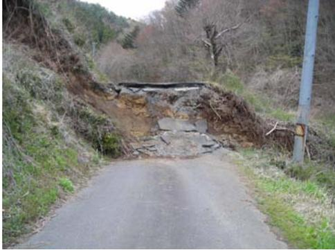
道路を寸断する断層変位。垂直方向の変位は約 190cm の西側低下。写真は西側から撮影。南北に断層変位が連続する。
