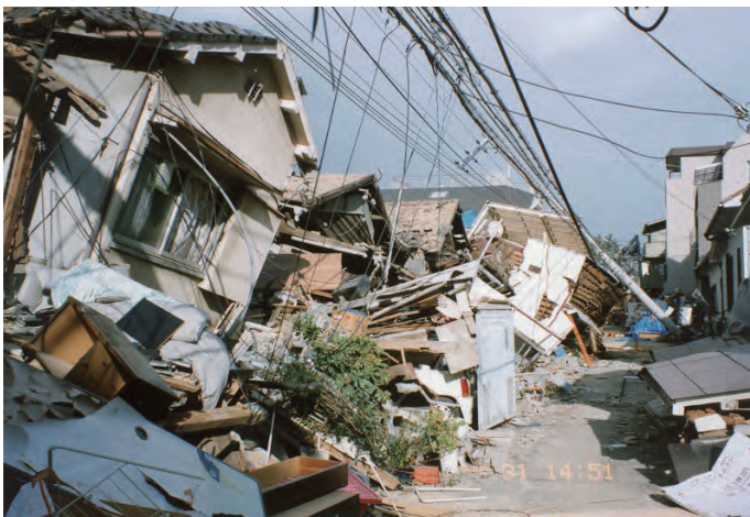
家屋の倒壊(兵庫県神戸市灘区)
