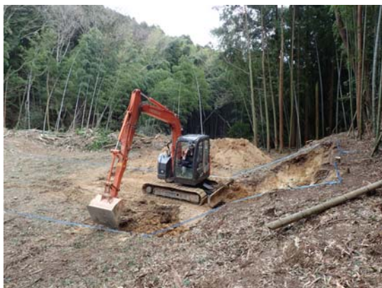
掘削時の様子
