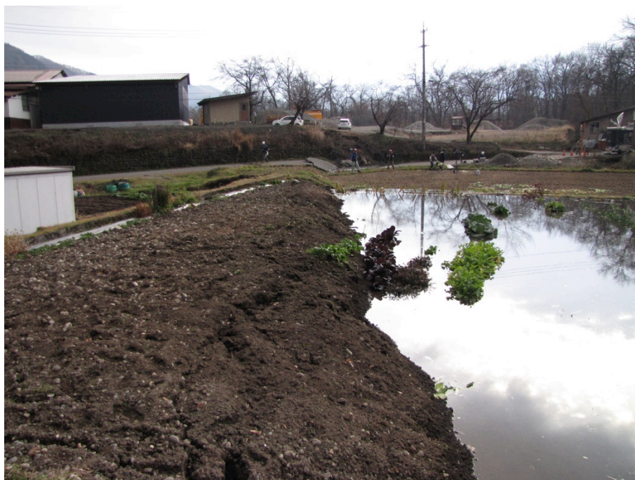
写真1 白馬村塩島集落，畑，田圃および道路にみられる撓曲変形．写真は南へ向かって撮影．上下変位量は90cm.
