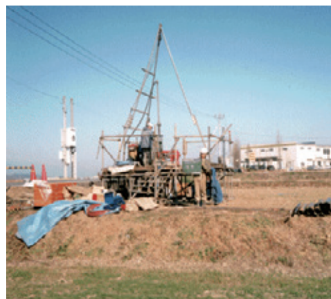
深谷断層帯のボーリング調査 （群馬県藤岡市） 写真提供：群馬県
